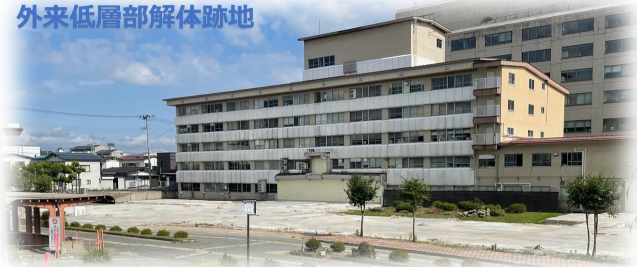
旧看護師寮 解体跡地
