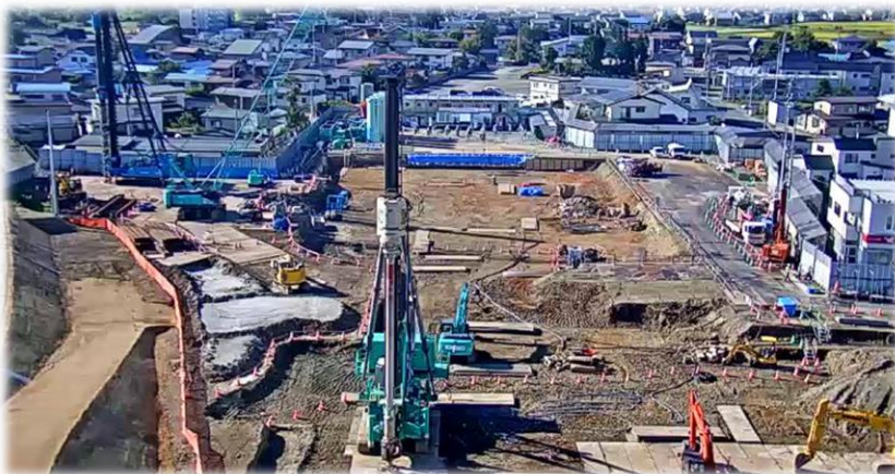
(北側から見た柱状改良工事)
