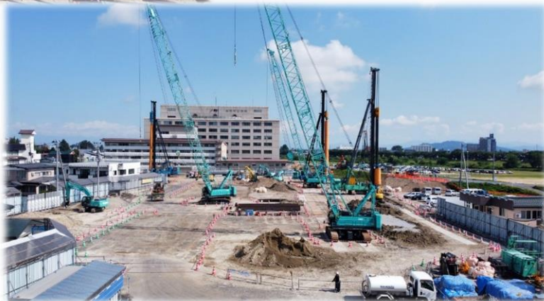
(南側から見た山留工事)
