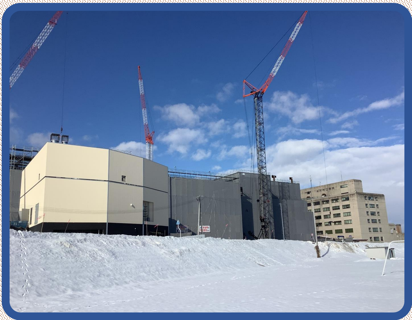
雪上から望む建設中の新病院
